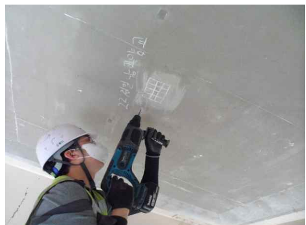
탄산화깊이 측정 현황
